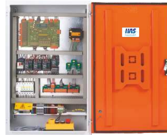
Hệ thống điều khiển hai tốc độ
